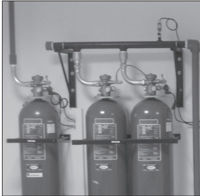
*Figura 1.2. Sistema de extinción de un CPD*
